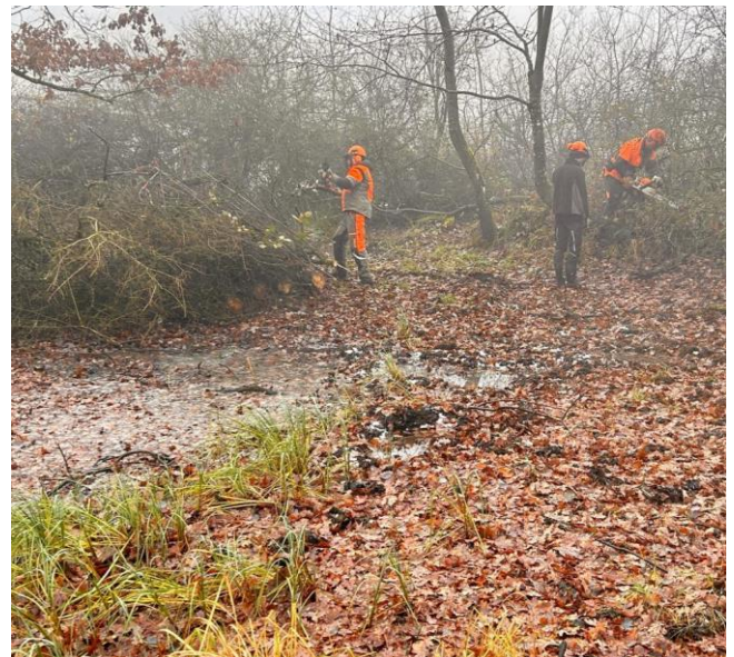
Entbuschungsarbeiten und verlandete Gewässerbereiche an der Kühtränke Eitensheim.
